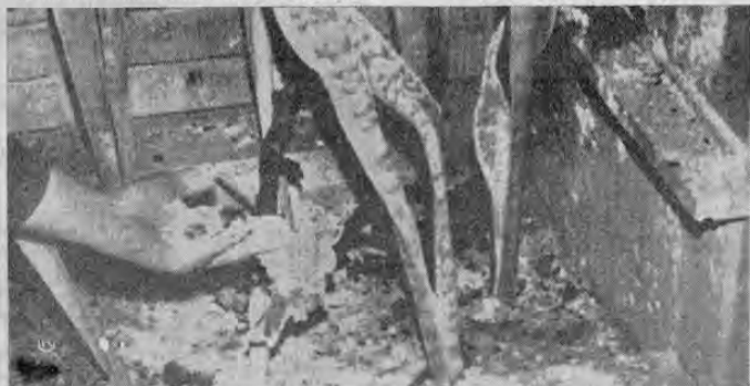
En este macetero cayó la bomba arrojada anoche contra la entrada del Laboratorio de Idiomas de la Embajada de los Estados Unidos, a eso de las ocho y treinta. Nótese los fragmentos de
